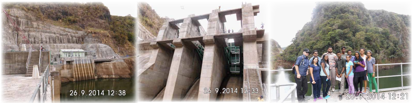
Nadarivatu Dam site
